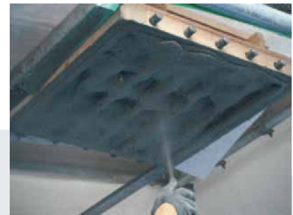
● 鉄筋背面への充填性試験
